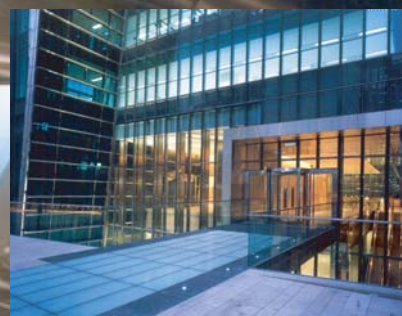
DONGBU KANGNAM TOWER (韓国) 床ガラス
